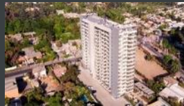
Edificio Vista Walker Martínez La Florida
