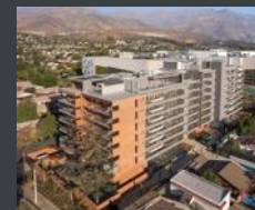
Edificio Río Guadiana 8745 Las Condes
